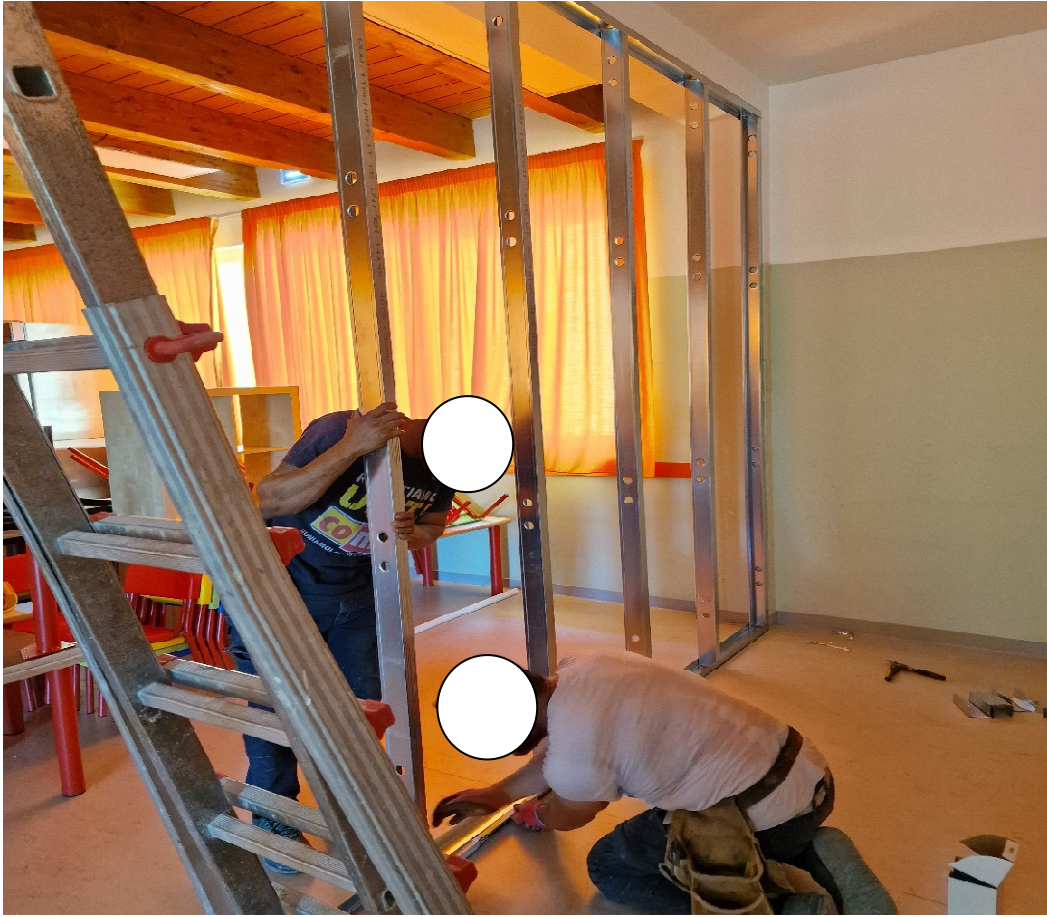
Foto 01 - Compartimentazione Area di Cantiere
