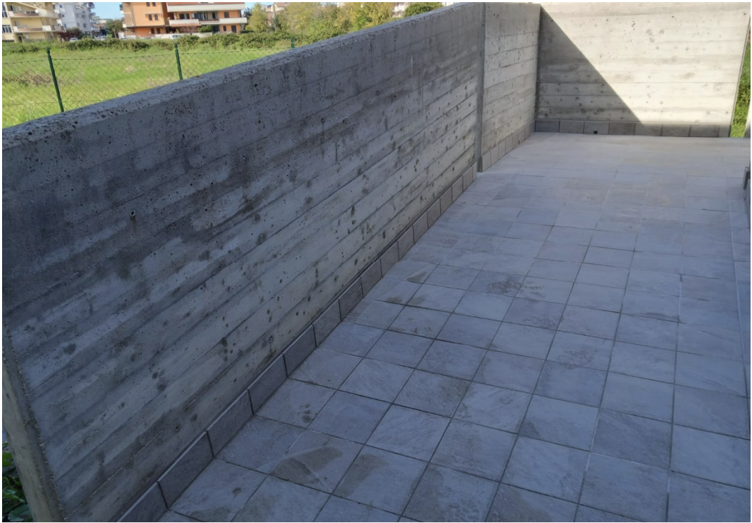
Foto 15 – Sistemazione Rampa ext
