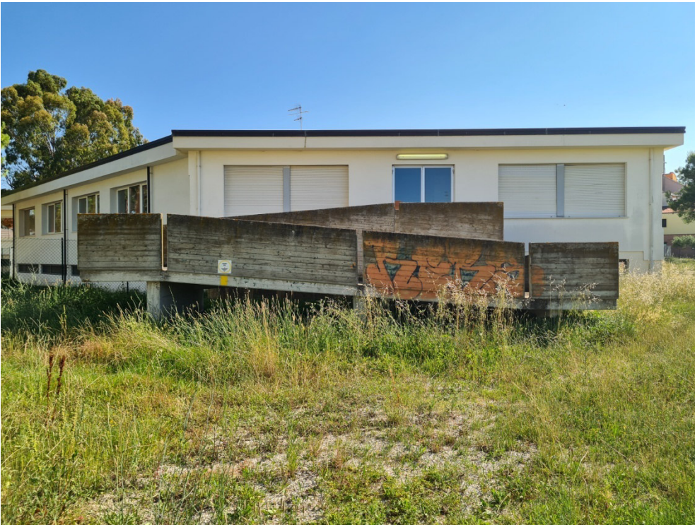
Area esterna . Uscita di sicurezza
