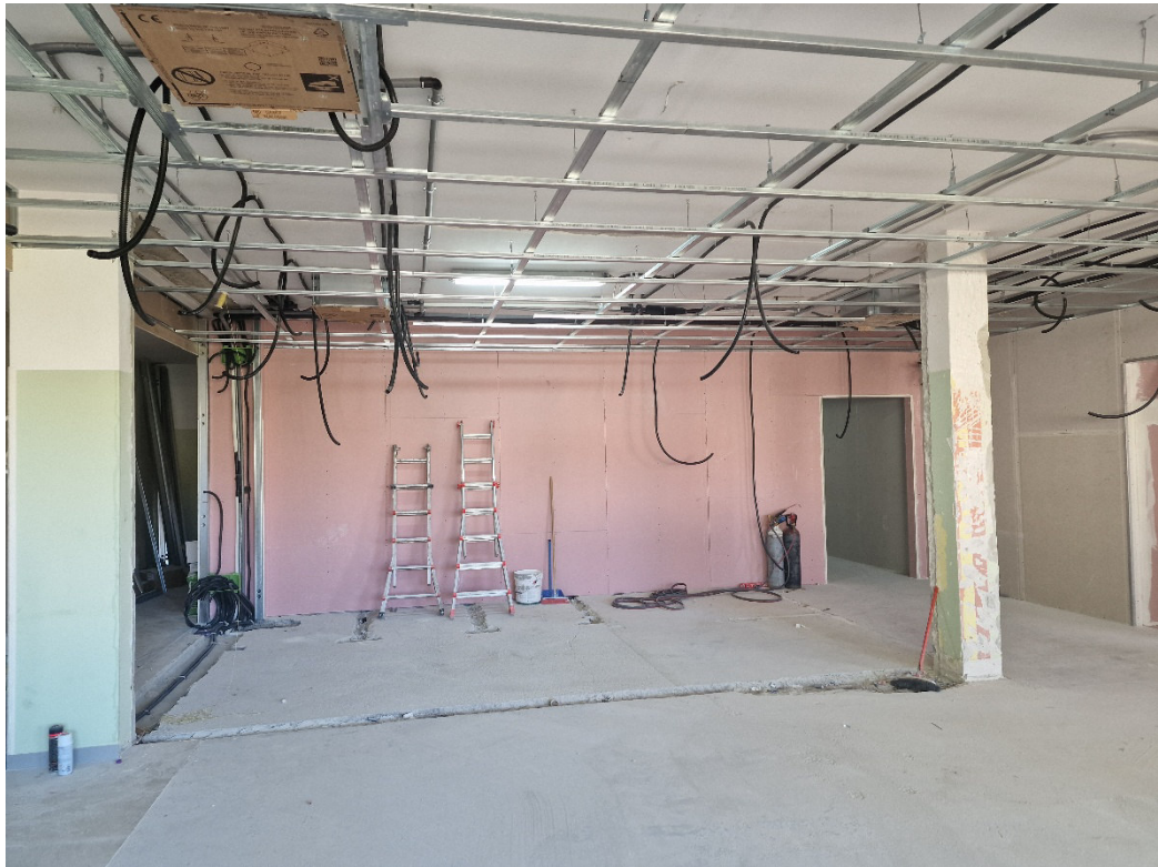
Foto 05 - Realizzazione Controsoffitti
