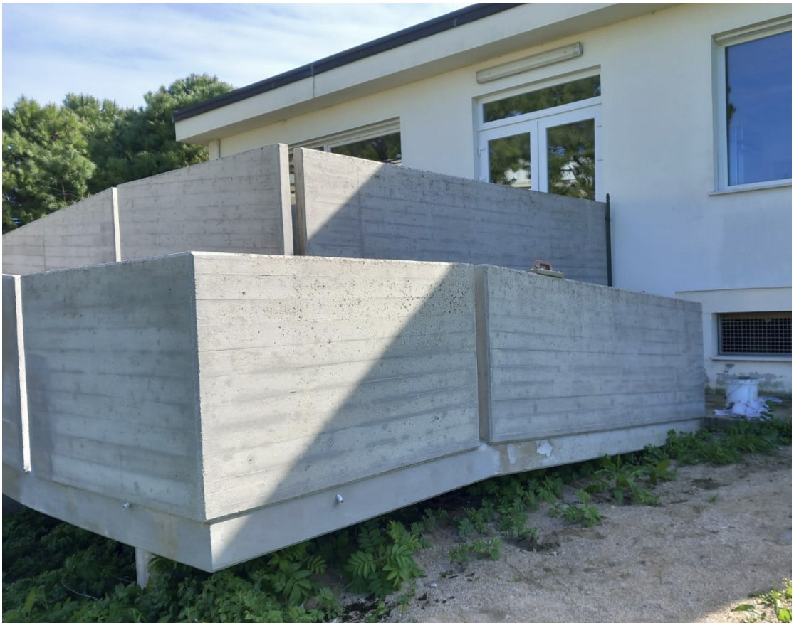
Foto 16 – Sistemazione Rampa ext
