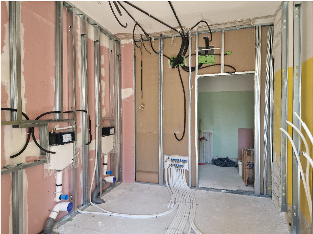
Foto 04- - Installazione Impianti su contropareti
