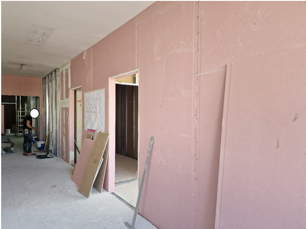
Foto 03 – Realizzazione Pareti a secco
