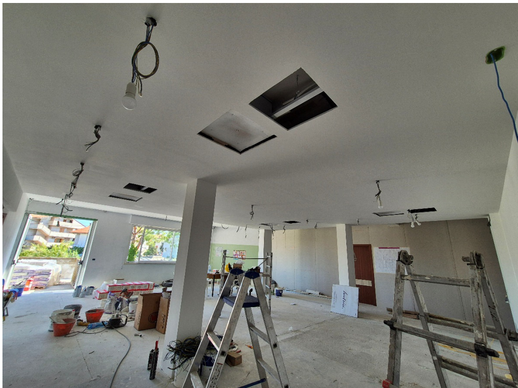
Foto 06- Realizzazione Controsoffitti
