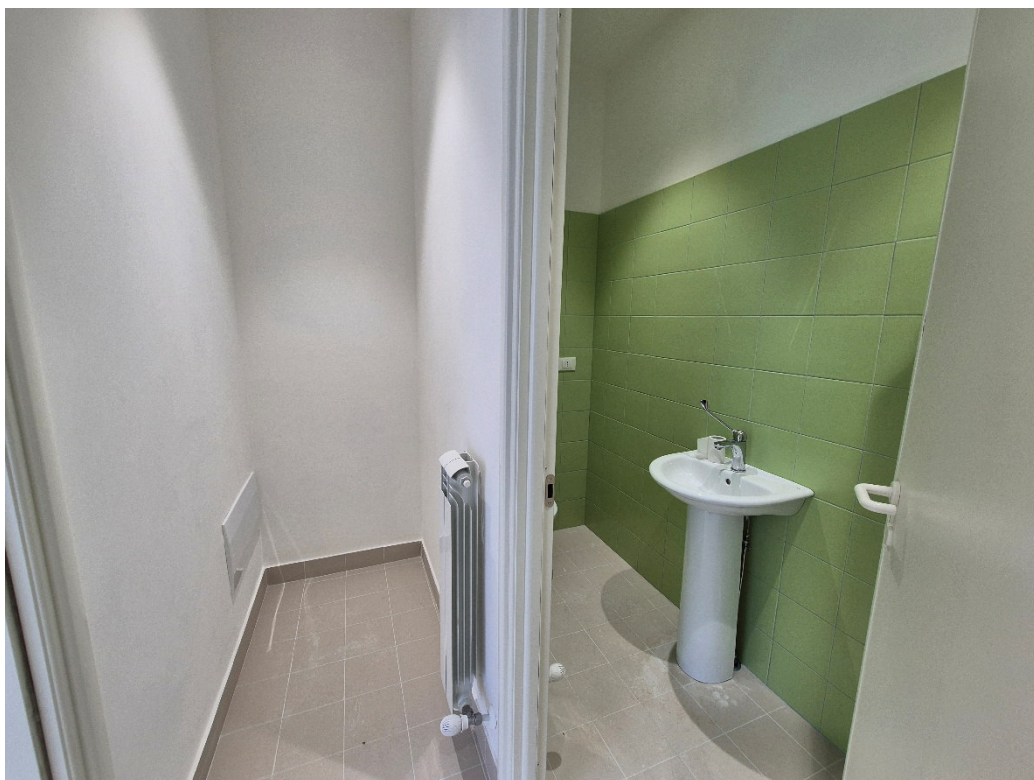
Foto 13 – Nuovi servizi igienici per addetti alla cucina
